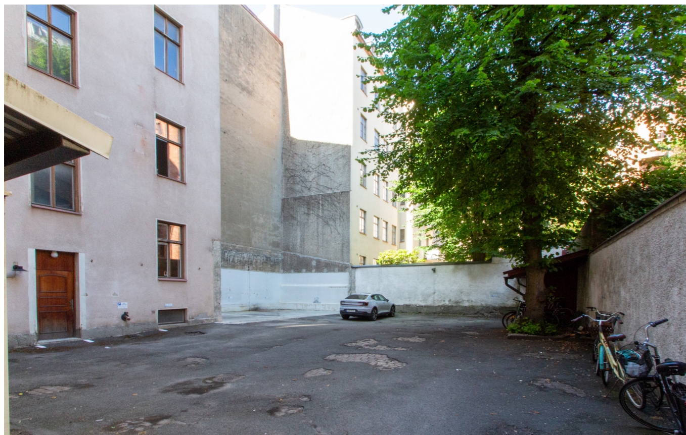
Gårdssidorna på fastigheterna är i regel utformade på ett betydligt enklare sätt än fasaderna mot gatorna. Bilden från Viktoriagatan 24.
